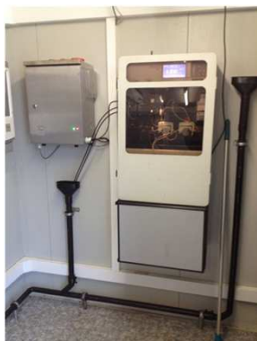
NH4-N Analyse Vollautomatisches Online Analysegerät zur Messung von Ammoniumstickstoff NH4-N. Messintervall 10 Minuten Gerät links: Probenvorbereitung
