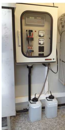
Säurekapazität Vollautomatisches Online Analysegerät zur Messung des Säurebindevermögens. Messintervall 10 Minuten. Diese Gerät ist nur in der kalten Jahreszeit in Betrieb wenn Kalkmilch zudosiert werden muss.
