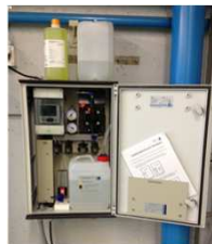
Vollautomatisches Gerät zur Reinigung der Keramikkerze.
