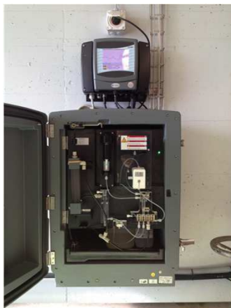
Vollautomatisches Gerät zur Reinigung der Keramikkerze.
