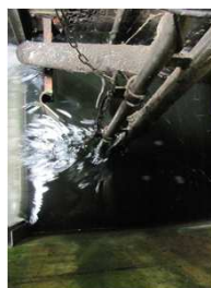
Pumpe im Auslaufkanal zur Beschickung des Probenbeckens
