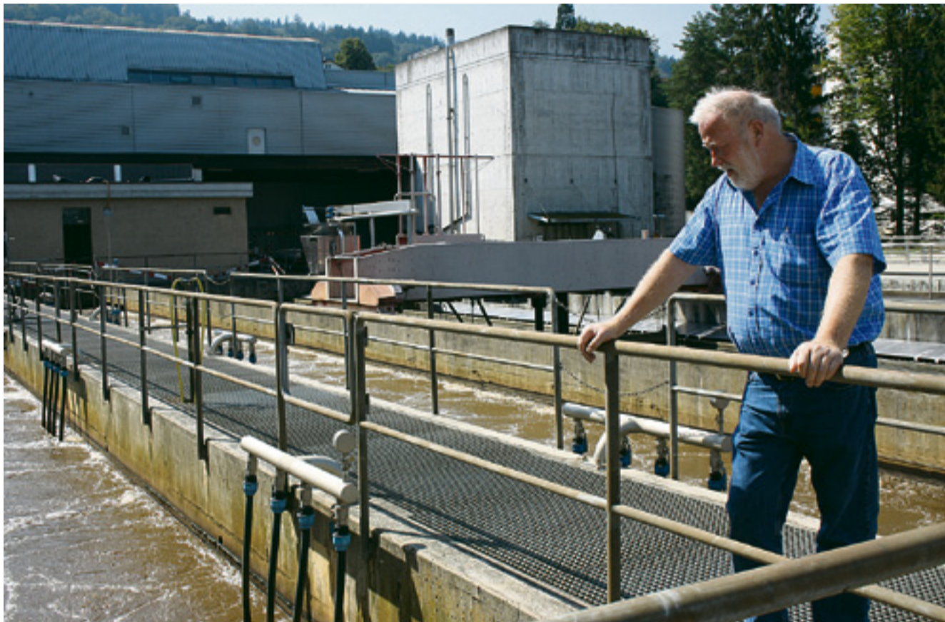
Aus Biogas wird Strom. Klärwerkfachmann Peter Gadliger findet das eine raffinierte Sache. Bild: Brigitt Hunziker Kempf
